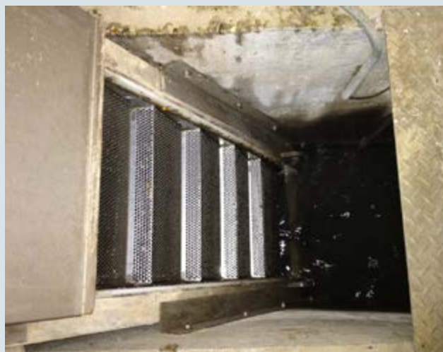
Fig. 6. Avløpsvann mottakpumpehus og rist før og etter bruk GREASOLUX
