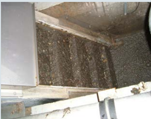
Fig. 6. Avløpsvann mottakpumpehus og rist før og etter bruk GREASOLUX
